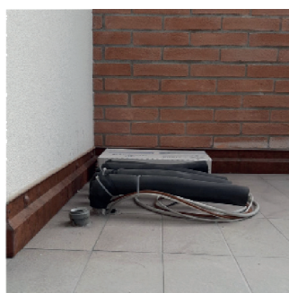
Esempio installazione con tubazioni dal pavimento
